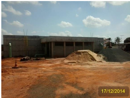
TC/PAC 168/2012 – Cerquilha - Vista geral do reservatório
