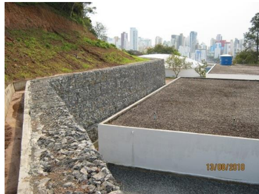
Contenção e Drenagem no entorno do reservatório (R1) da EMASA
