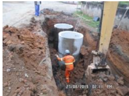
Execução de poços de concreto EE-MB03
