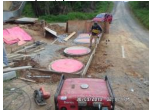
Montagem de formas das lajes EE-MB06
