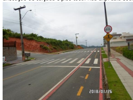
Sinalização vertical instaladas Rua Tarcísio Vanderlinde
