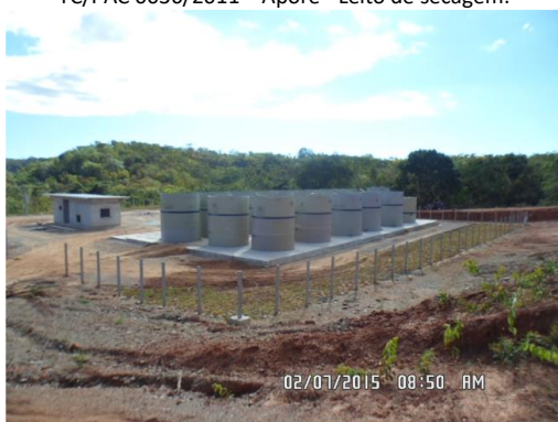
TC/PAC 0203/2012 – São Domingos - ETE
