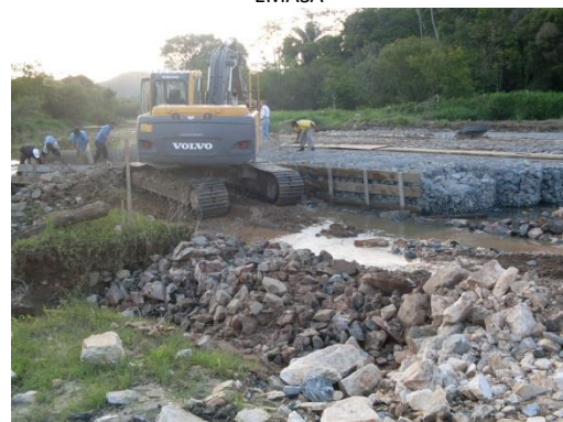
Reestruturação da Unidade de Captação de Água Bruta da EMASA
