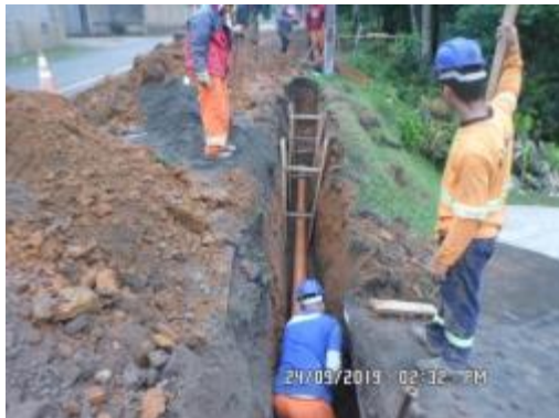
Assentamento de tubos Rua José Cordeiro
