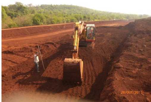
TC/PAC 285/2012 – Sales Oliveira - Escavação mecânica da 4ª lagoa
