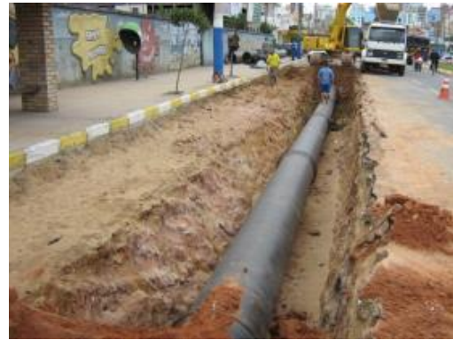
Adutora Avenida do Estado
