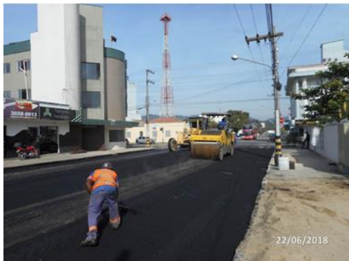
Execução de pavimento asfáltico Rua Sen. Raulino Horn
