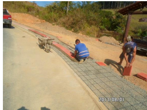
Execução de calçada e piso tátil Rua Exp. Luiz Coan
