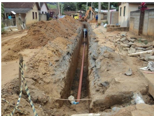
TC/PAC 0096/2011 - São Gabriel da Palha -Implantação da Rede Coletora
