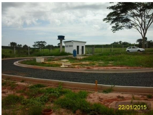
TC/PAC 793/2009 - Monte Aprazível - Vista geral do sistema de tratamento
