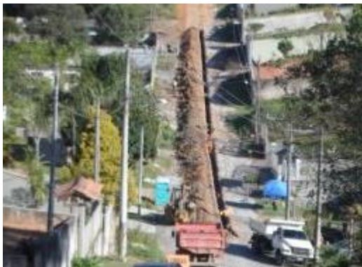
Assentamento de tubos na Rua Ernesto Beckert
