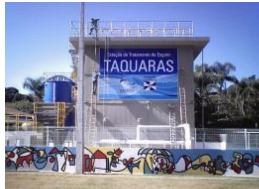
Estação de Tratamento de Esgotos na Praia de Taquaras
