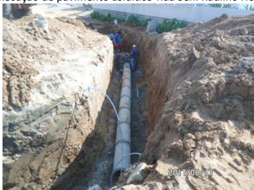
Rede de drenagem Rua Wilibaldo Gesser
