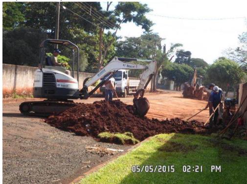
TC/PAC 0106/2012 – Sertaneja - Escavação mecânica de valas na Rua Rocha Pombo
