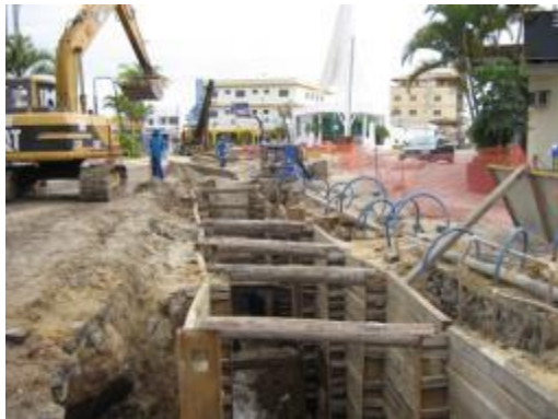
Ampliação da Rede coletora de Esgoto Doméstico – Distrito Sanitário 3.1 - Avenida do Estado
