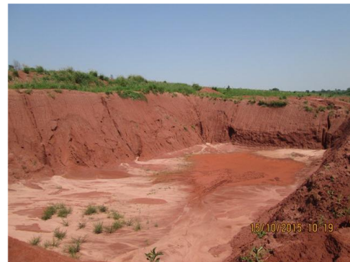
TC/PAC-0006/2012 – Amaporã - Escavações executadas em meses anteriores no terreno da ETE.
