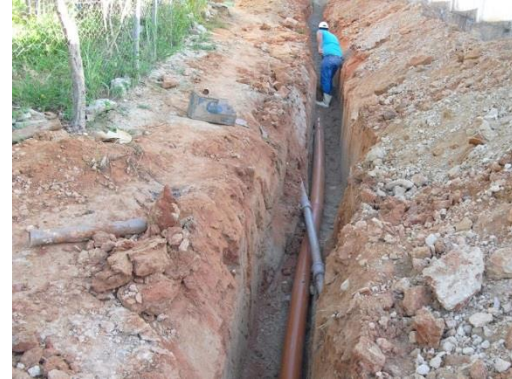
TC/PAC 0294/2007 – Vila Pavão - Implantação da Rede Coletora
