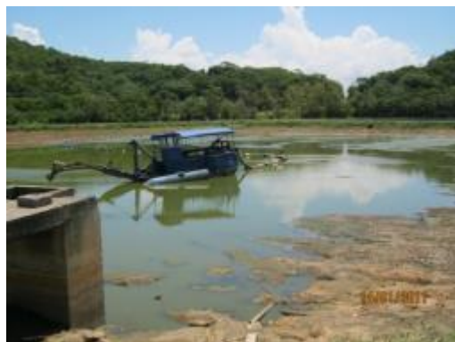
Desassoreamento Lagoa ETE
