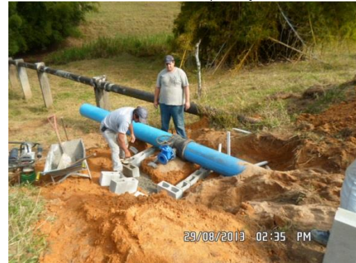
TC/PAC 0118/2011 - Guaçuí - Execução de descarga da adutora em área rural
